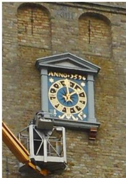
Wijzerplaat 1596 toren Nicolaaskerk Nijland. Voor de restauratie was een hoogwerker nodig. Foto mei 2019
